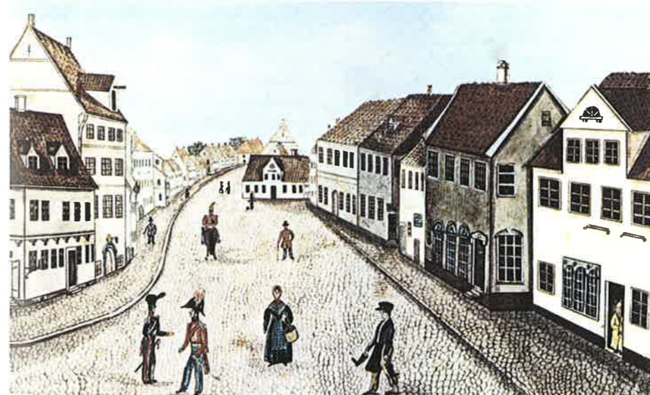
På Skjolden i Overgade forsynede odenseanerne sig fra en vandpost, indtil de fik private vandhaner. Tegning ca. 1840, Møntergården.
